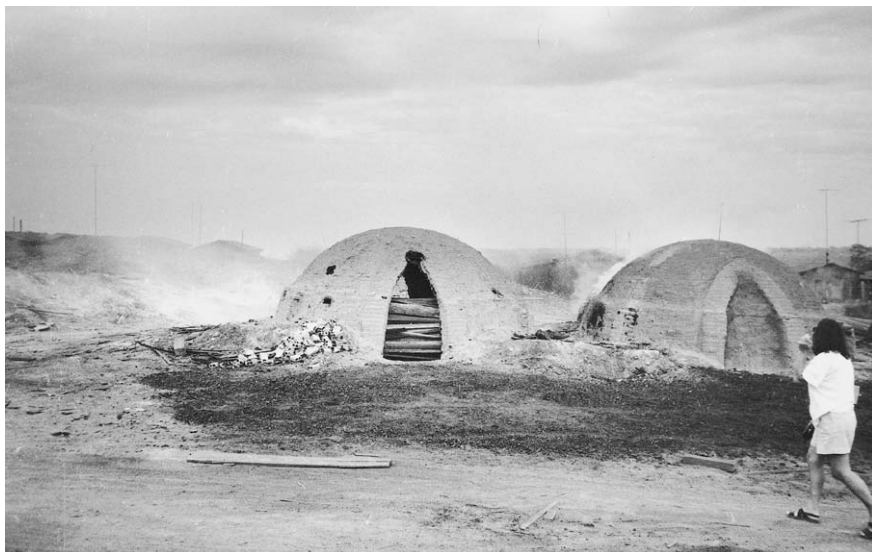
Foto 20: Carvoaria instalada em Paragominas (PA), que utiliza resíduos de madeira serrada para produzir carvão vegetal.
