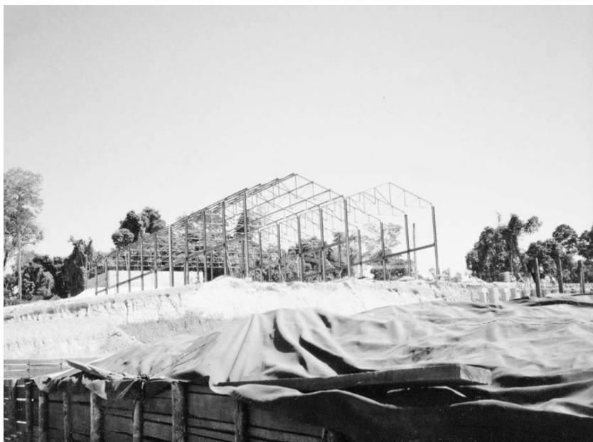
Foto 4: COSIPAR durante a sua construção em setembro de 1987.
